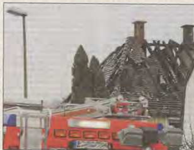
Die Wucht der Explosionen hat an dem Gebäude in Zell Wände nach außen gedrückt und Decken weggerissen, wie die Feuerwehr mitteilte. Foto: Kai
