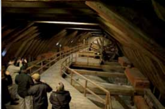
Rettungsweg aus der Turmstube des Freiburger Münsters: Abgang in den Dachstuhl, Weg im Dachstuhl mit historischem Lastkran
