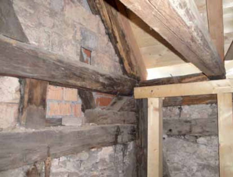
Dachkonstruktion einer Remise mit Ergänzungen in Weinstadt-Strümpfelbach
