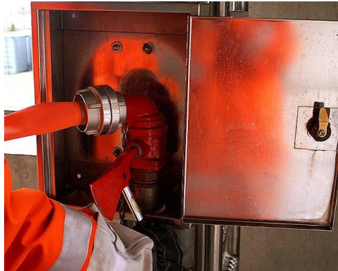
Abbildung 7: Beispiel für Löschwasser-Entnahmeeinrichtung (Quelle: LFS Baden-Württemberg)
